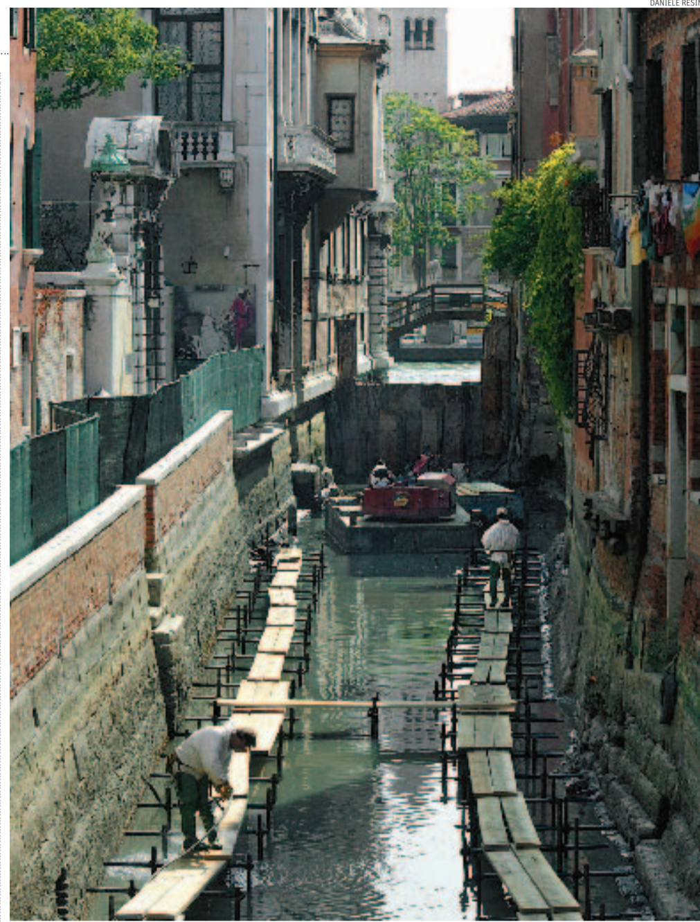
Venezia. L'immagine documenta l'intervento effettuato nel giugno 2003 lungo il Rio di San Barnaba
